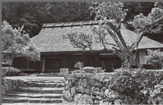
永沼家住宅 国指定重要文化財(建造物) (みやこ町犀川帆柱721)
